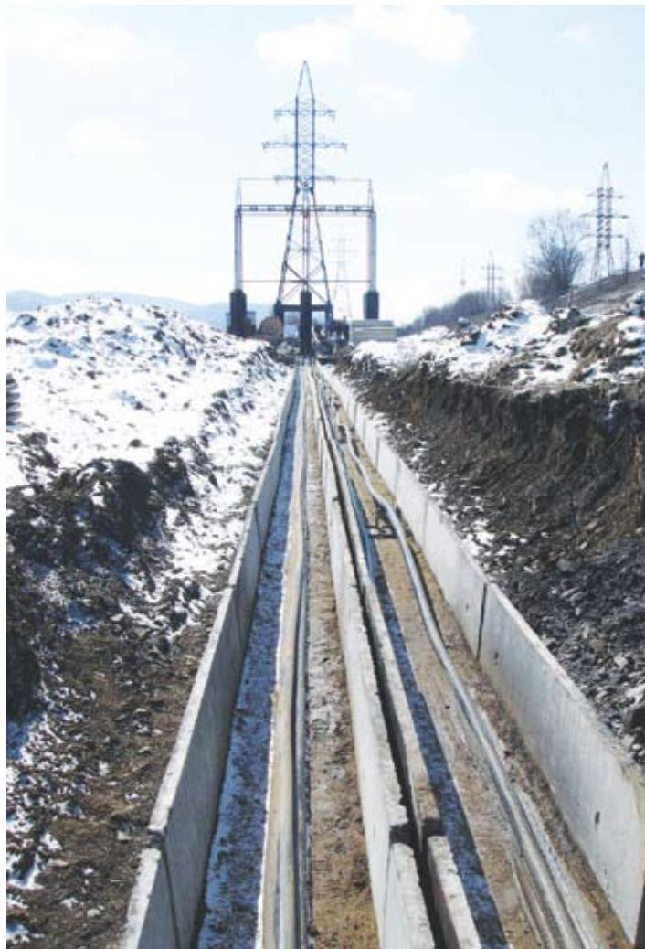
При прокладке кабелей с СПЭ-изоляцией на напряжение 110-220 кВ радиус изгиба не должен быть менее  $20xD$ , где  $D$  – наружный диаметр кабеля. После прокладки по трассе допускается изгиб кабелей с радиусом  $15xD$  при условии использования специального шаблона (например, у концевых муфт и в других случаях).
